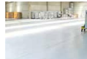
Pavimentazione interna in multistrato epossidico
